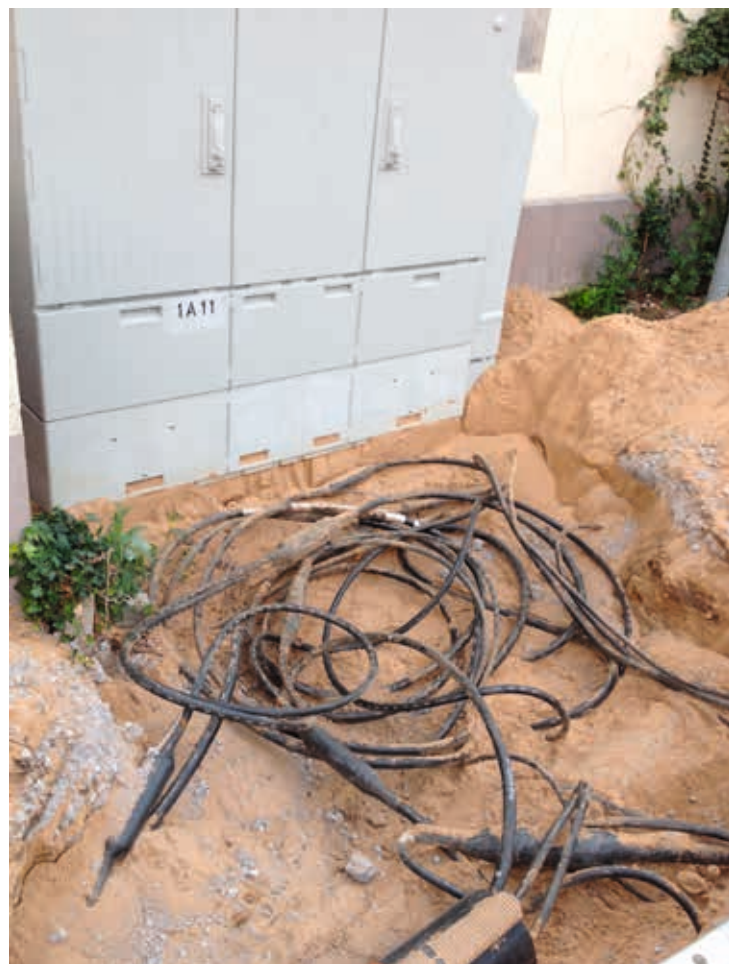
Bis tief in das Zentrum der Ortschaften in der Gemeinde Kranenburg wurden die schnellen Glasfaserleitungen in den letzten Monaten gelegt.
