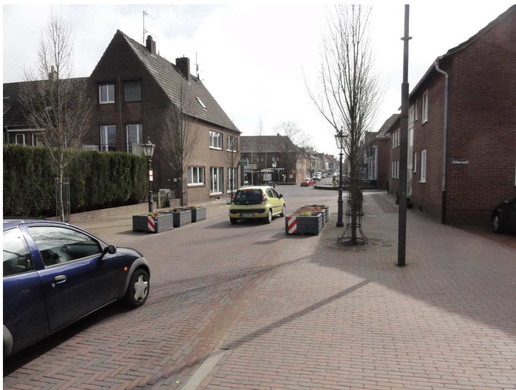
Bild 6 Situation der Großen Straße auf Höhe Hausnummer 77 – Engstelle mit ca. 4,30 m Breite
