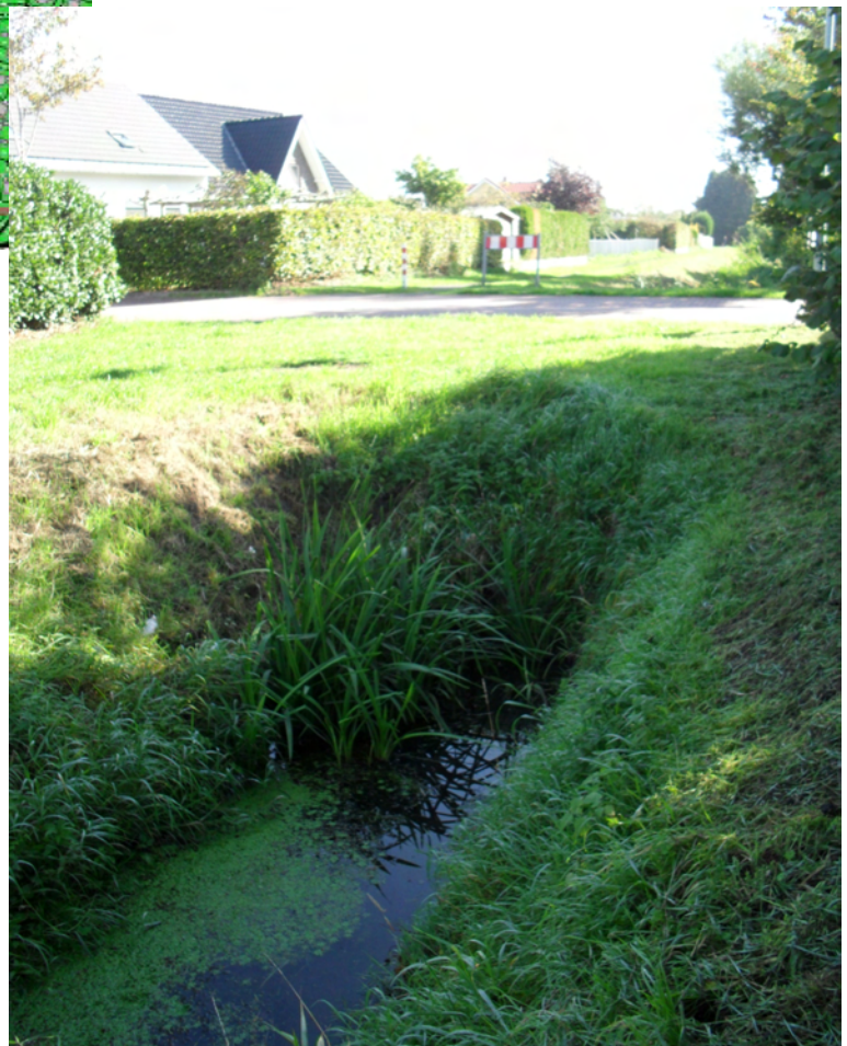
Foto der Einleitungsstelle (Anschluss der Entwässerungsleitung liegt im Durchlass)
