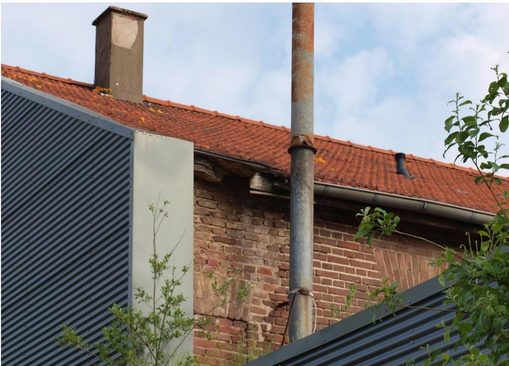
**Foto 8:** Teilweise beschädigte Gebäudestrukturen am Bestandsgebäude
