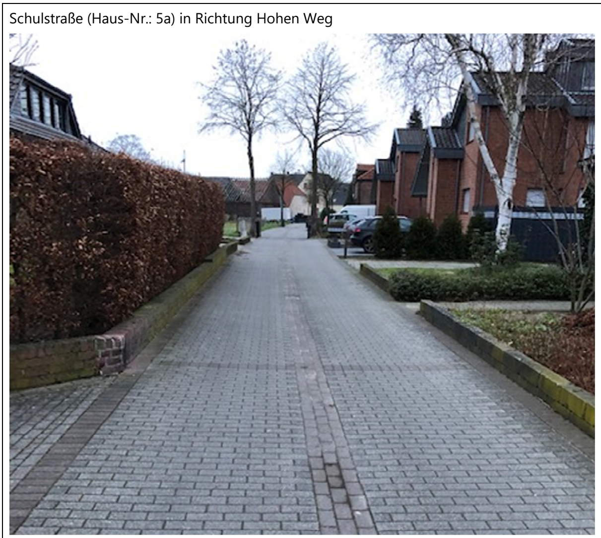
Abbildung 6 Darstellung der aktuellen Situation in der Schulstraße im Februar 2020 Höhe Haus-Nr.: 5a
