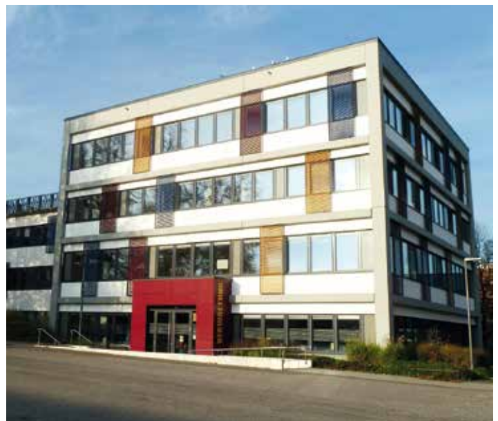
Neubau Passivhausstandard und Plusenergieschule Realschule Hoffmannallee
