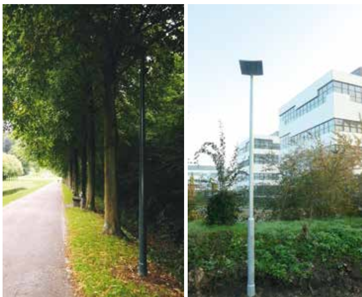
LED – Straßenbeleuchtung, Wegeverbindung zur Hochschule Rhein-Waal und Forstgarten
