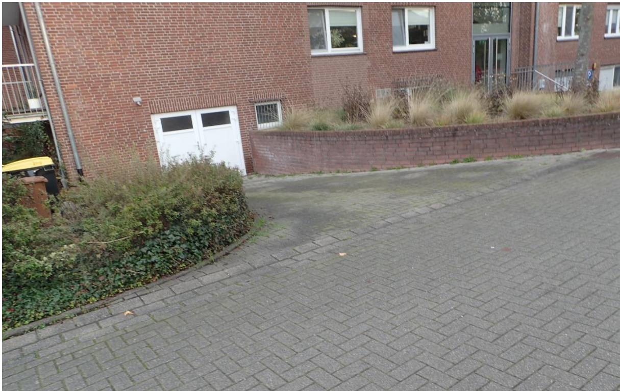
Abbildung 24: Beispiel einer tiefliegenden Zufahrt in einem überflutunggefährdenden Bereich
