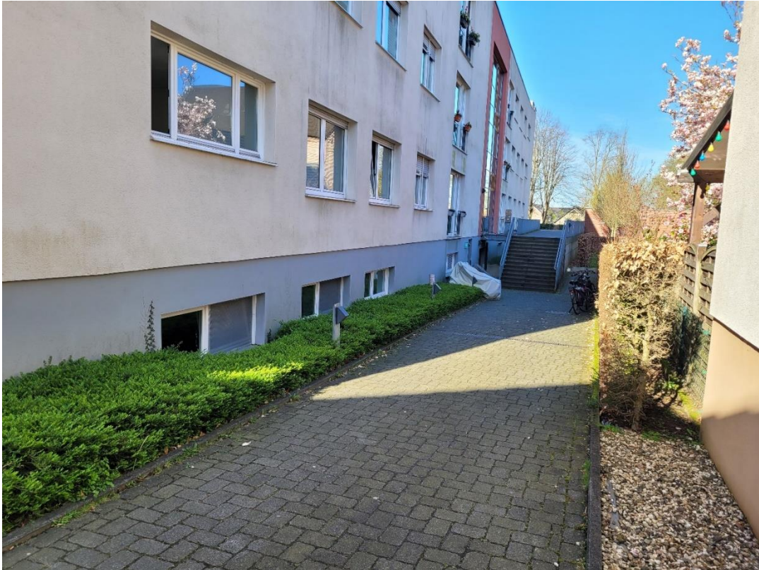
Abbildung 8: Zufahrt des Seniorenwohnheims St. Johannes-Stift Kranenburg GmbH, Ortsbegehung vom 14.04.2023
